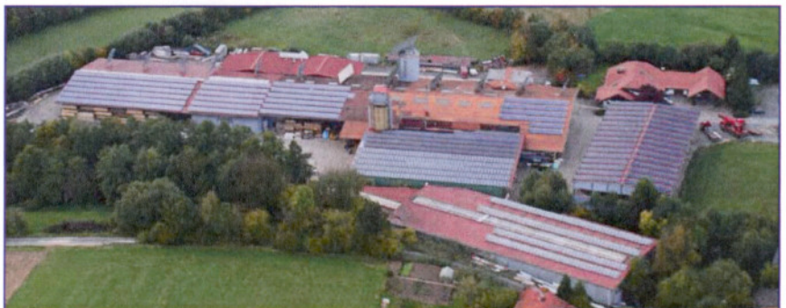
485.000 KWh bringt die Solaranlage auf dem Dach der Werkshallen. Bei guten Wetterbedingungen kann Baumgarten damit seinen Energiebedarf decken.
